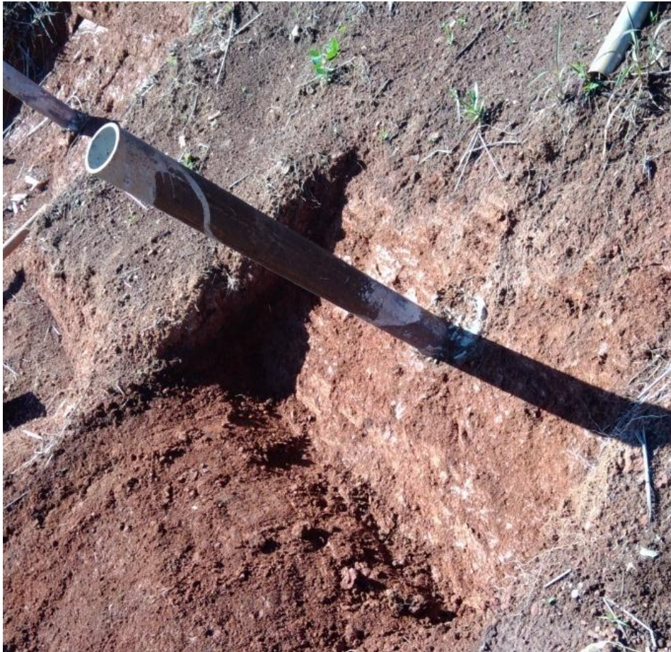
Figura 22 - Ajuste executado no talude ao redor da microestaca
