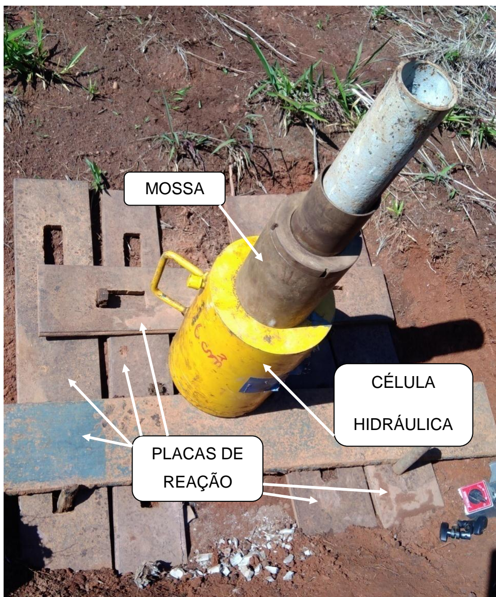
Figura 23 - Montagem das placas de reação, célula hidráulica e moessa de travamento
