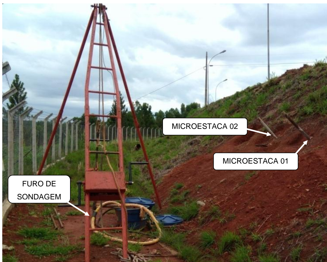
Figura 17–Talude estudado com a localização da microestaca e SPT
