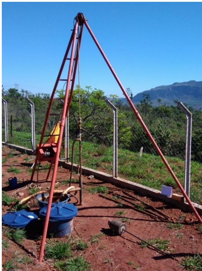
Figura 18 - Execução do ensaio de SPT
