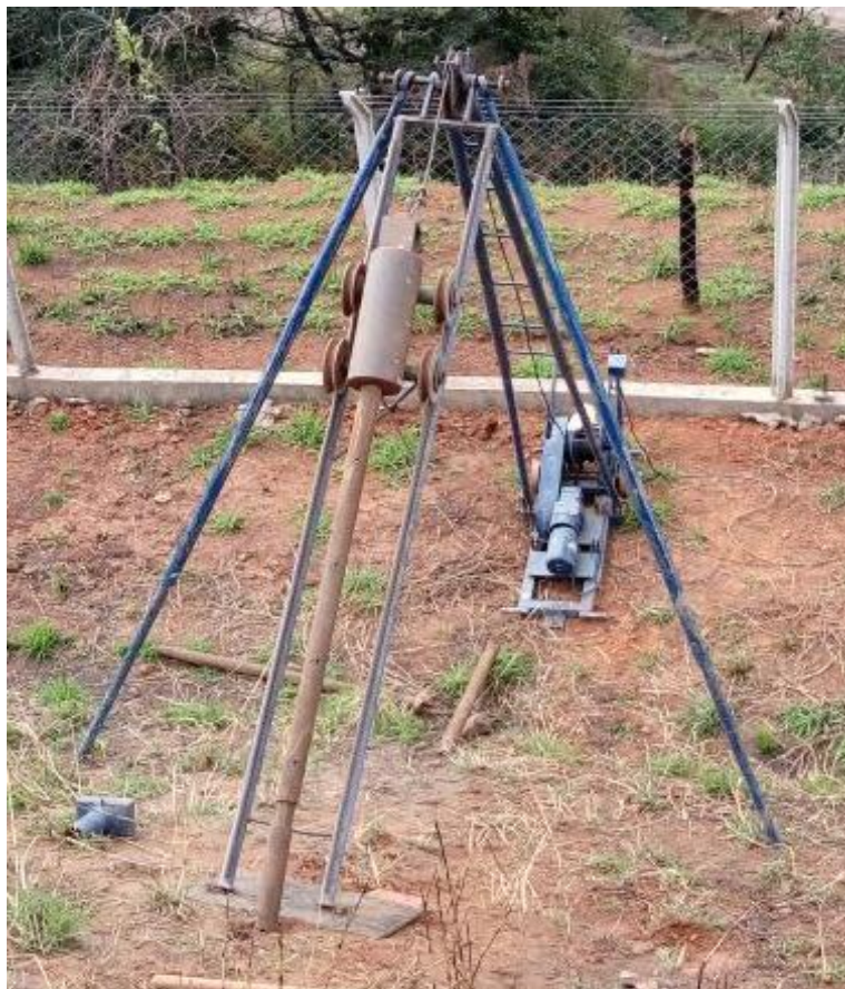
Figura 20 - Execução da microestaca no campo experimental
